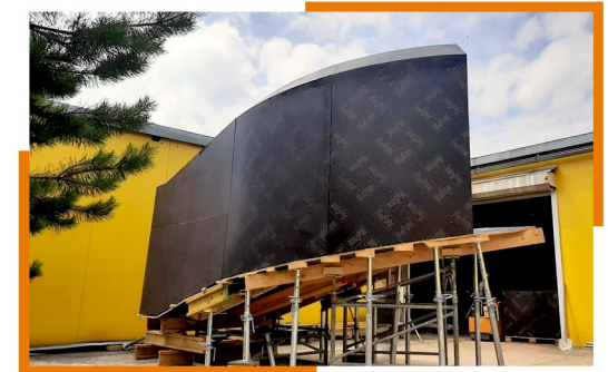
Montaż próbny formy kanału obiegowego śluzy na panelach systemowych H20
