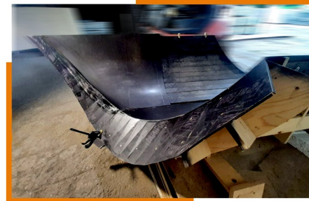
Skośny panel radialny R=0,80 m. Budowa śluzy - forma wybitki kanału obiegowego
